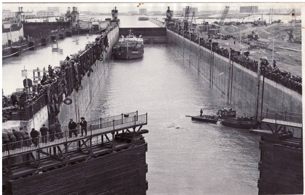
ПЕРВОЕ ШЛЮЗОВАНИЕ ПО ШЛЮЗУ 25 1968г
